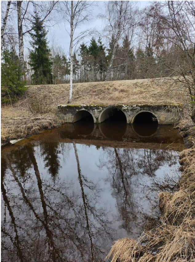
Foto 3. Lokuta jõe truubi T/53 väljavool. Truup jääb olemasolevasse seisukorda.
